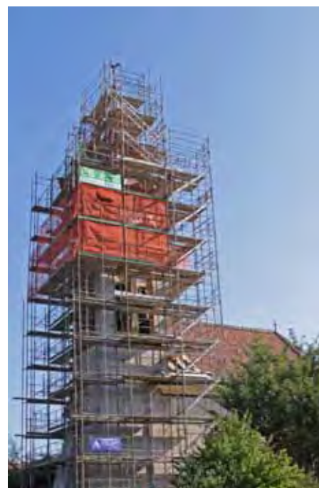
↑ Réfection du clocher en 2013 avec un échafaudage beaucoup plus présent.
