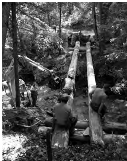
↓ ↑ Pose des 2 troncs d'arbre de nos forêts destinés à supporter la nouvelle passerelle
