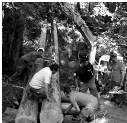
↓ ↑ Pose des 2 troncs d'arbre de nos forêts destinés à supporter la nouvelle passerelle
